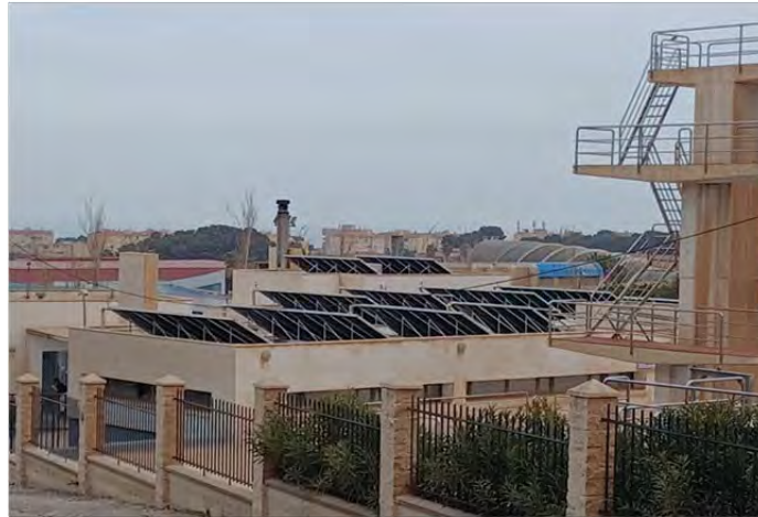
Sistema de captadores caldeo piscinas
