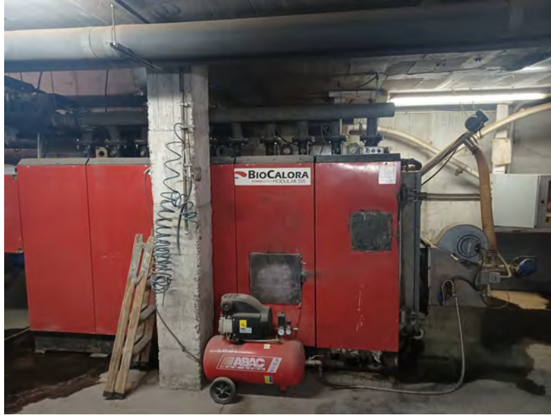
Caldera BioCalora (a sustituir)
