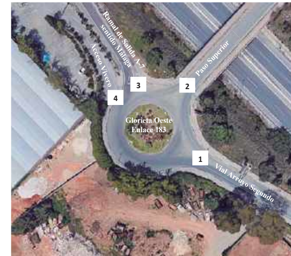
Ilustración 26. Acceso a Glorieta Oeste del Enlace 183
