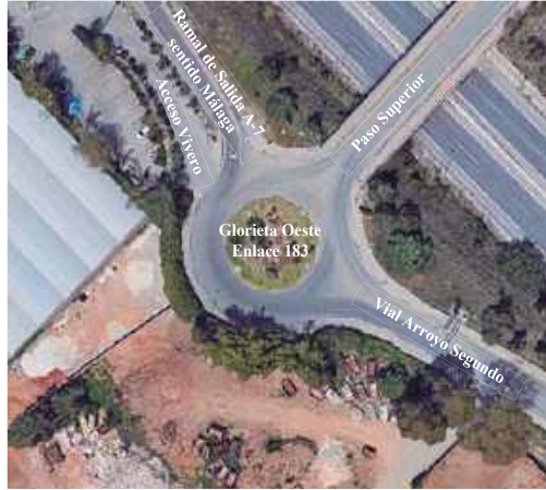
Ilustración 17. Acceso a Glorieta Oeste del Enlace 183
