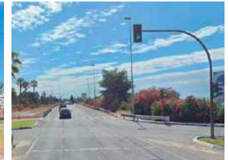
Ilustración 10. Control semafórico del ramal de Incorp. 184 Marbella / Centro Urbano / Polígono Industrial
