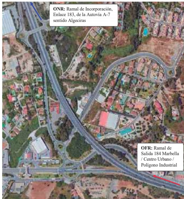
Ilustración 28. Configuración del tramo de la A-7 sentido Algeciras entre los enlaces 183 y 184
