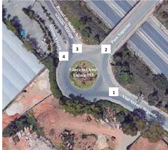
Ilustración 24. Acceso a Glorieta Oeste del Enlace 183
