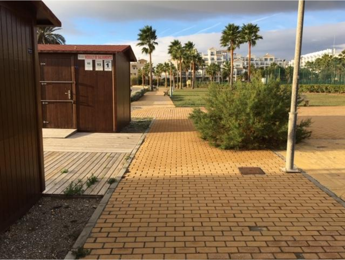
Paseo existente al oeste
